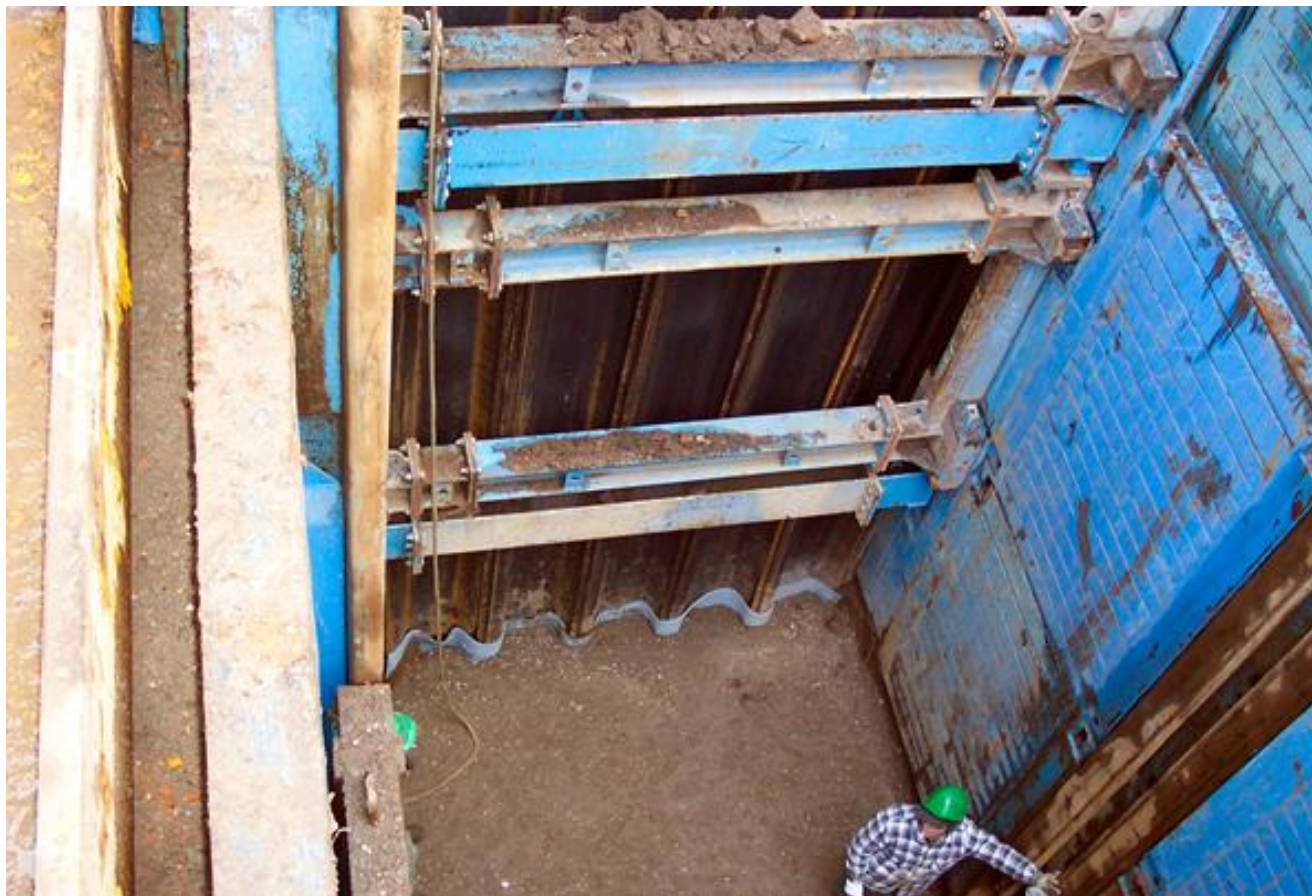
↑ Blindaggio di testata con palancole
