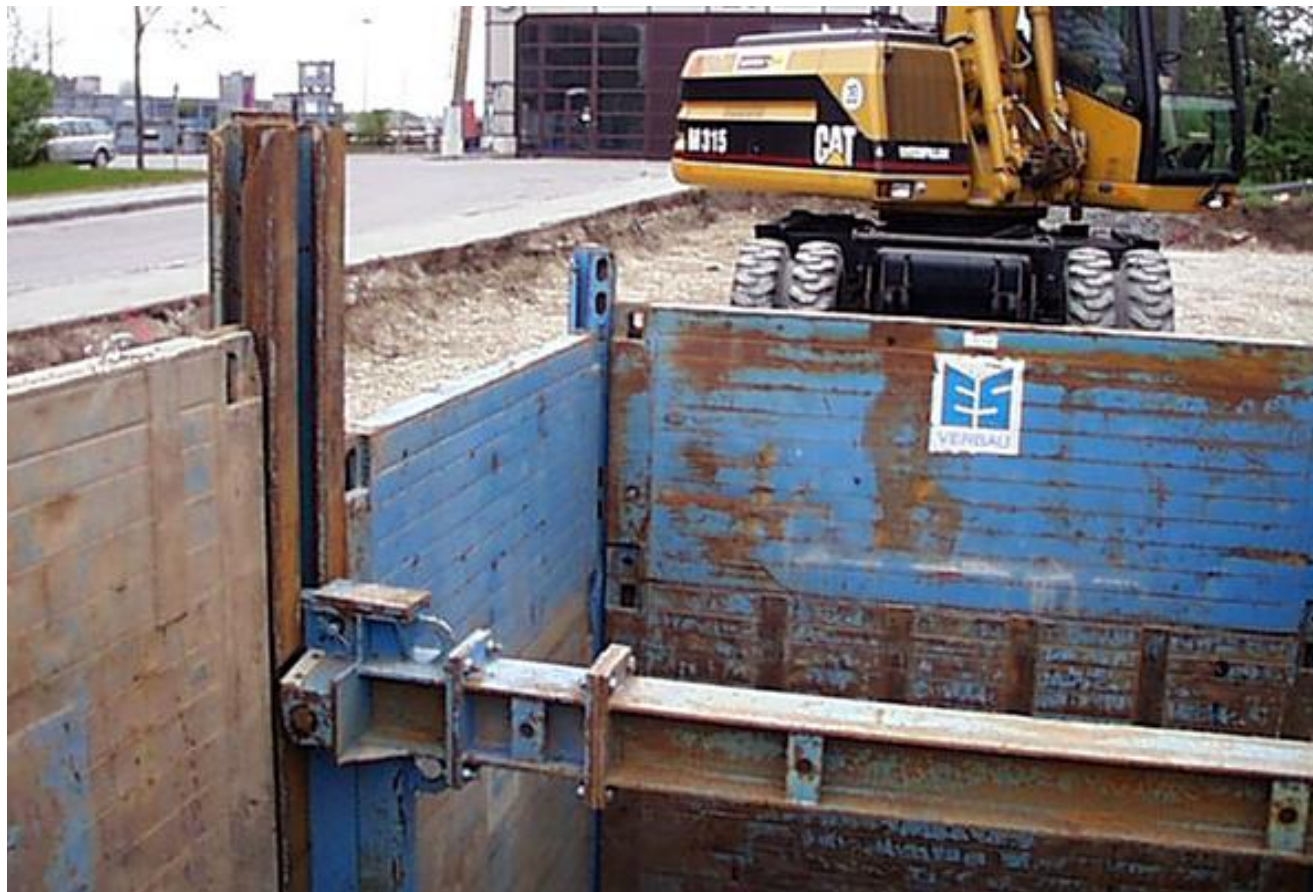
↑ Blindaggio ad angolo ad una rotaia
